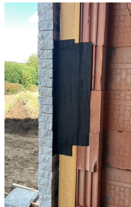
3. BUITENSPOUWBLAD + ISOLATIE + DEEL BINNENSPOUWBLAD
