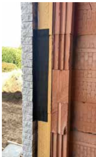
2. MUR CAVITÉ EXTÉRIURE + ISOLATION
