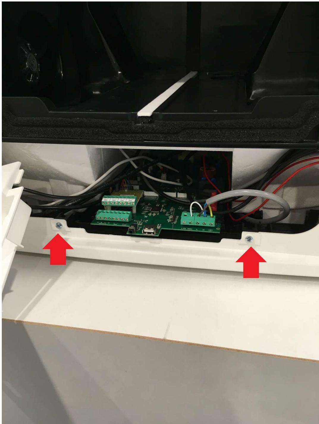
5. Het karkas van de unit kan nu verwijderd worden : trek de onderkant weg en dus die omhoog. Ter hoogte van de filterlades komen de weerhaken tevoorschijn en kan de karkas volledig verwijderd worden
