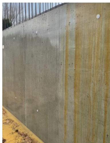
O.a. verwijderen van roest op beton met BELGACLEAN 201
